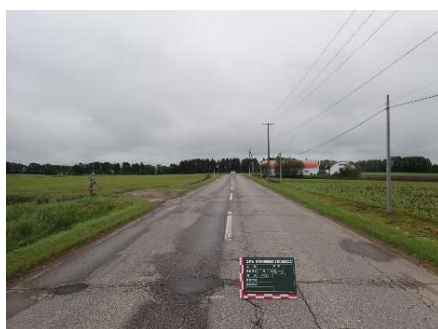
【現況】 舗装面のひび割れ、わだち掘れ障害
