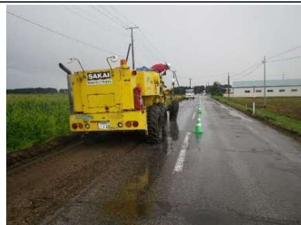
【施工】 一次混合状況（スタビライザ）
