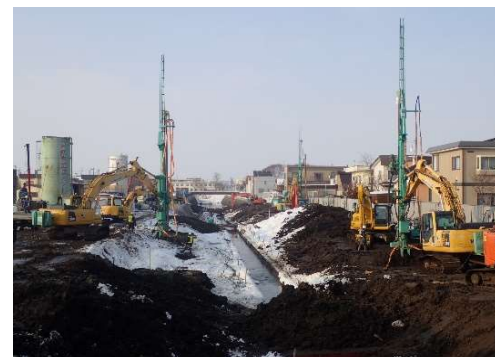
MITS工法施工状況
