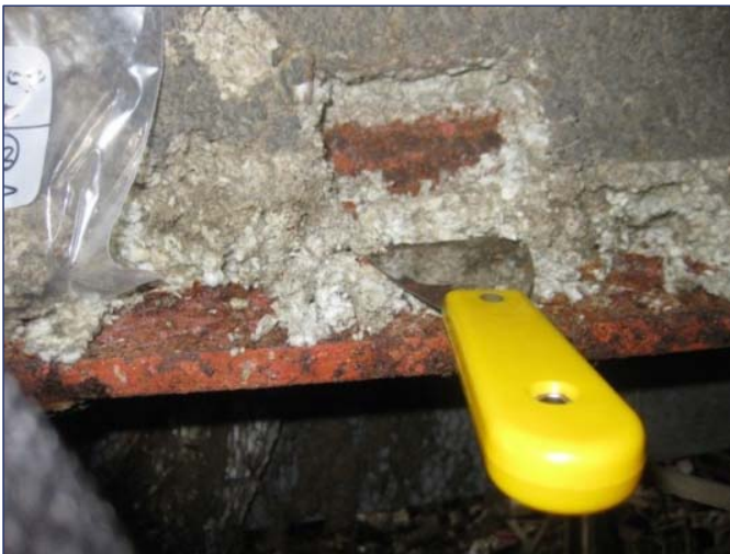
鉄骨吹き付け材
