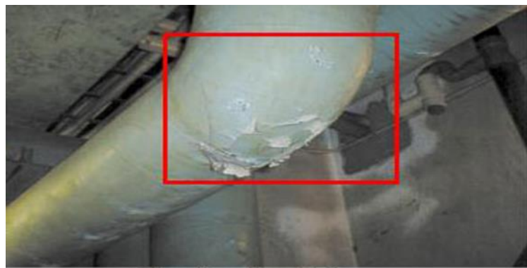
アスベスト含有保温材(配管保温用)
