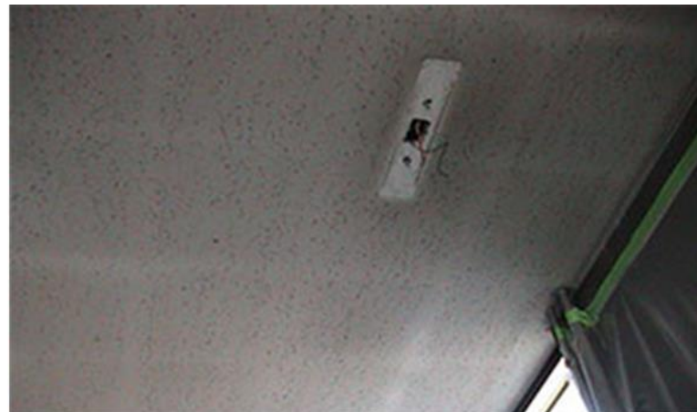
石綿含有ロックウール吸音天井板
