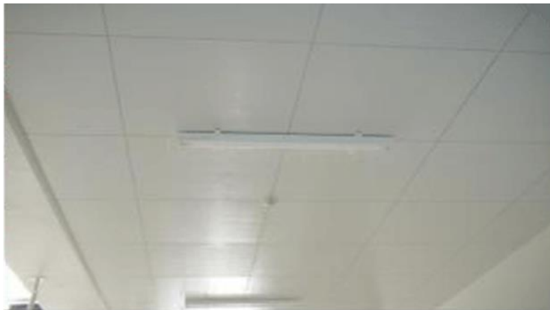
石綿含有ケイ酸カルシウム板(第1種)
