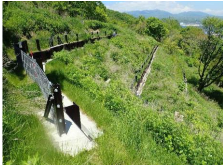
(土留柵工の全景)
