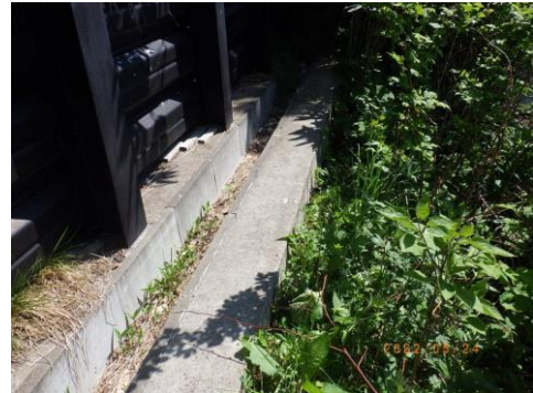
(排水施設の点検状況(排水トラフの土砂除去))
