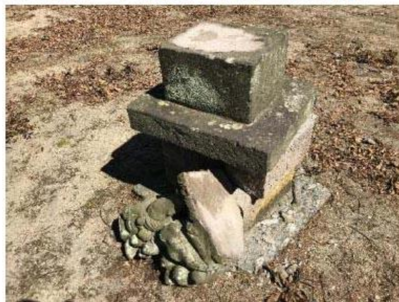
写真 5.2.14 寺社建築 C 付近の工作物の破壊状況
