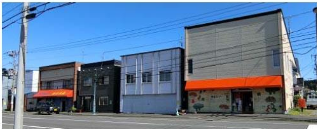
写真 5.3.25 店舗併用住宅が建ち並ぶ通り
