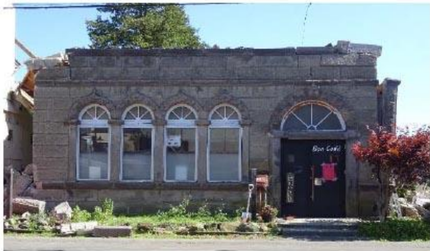
写真 5.3.15 比較的古い組積造の2層の崩壊
