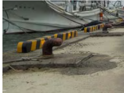
復旧前（岸壁の被災状況）
