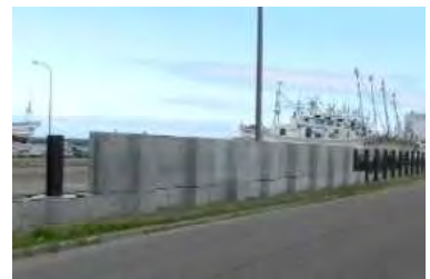
施設整備状況
