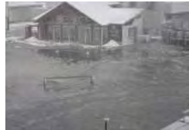
背後家屋被害状況
