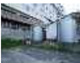
屋外貯蔵タンク (2基)
