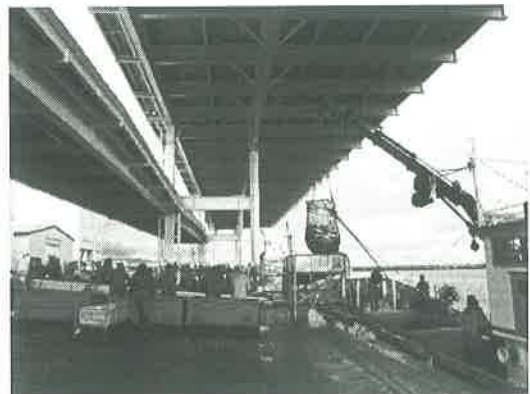
■衛生管理型の屋根付き岸壁
