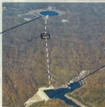
京極発電所全景
