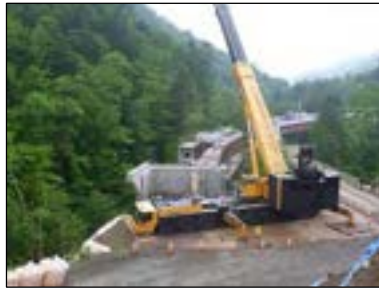
アクセス道路の整備 (道道美咲富良野線)
