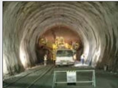
北海道新幹線 ニツ森トンネル工事 (倶知安町・仁木町)
