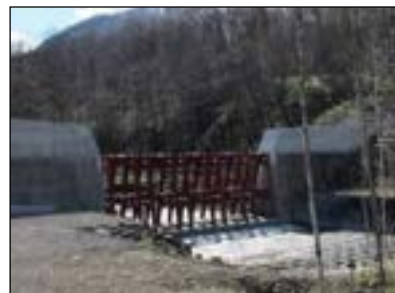
土石流等を捕捉する砂防堰堤
