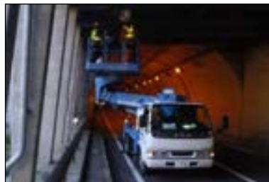
シールド点検の作業状況
