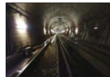
青函トンネル (三線式軌道)
