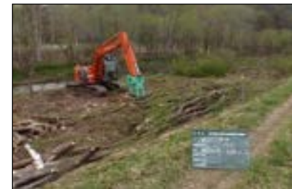
河道内樹木の伐採
