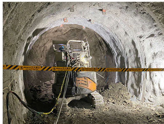
(b) 掘削の様子
