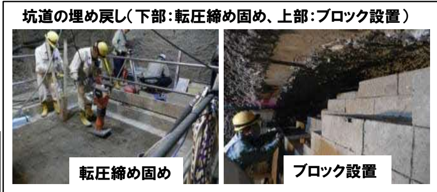
坑道を埋め戻す複数の施工方法を確認します
