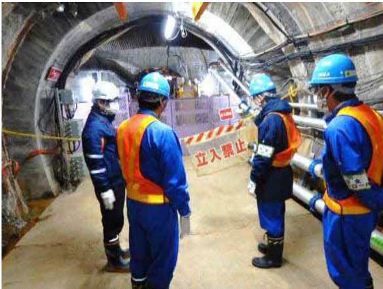
安全パトロールの様子
