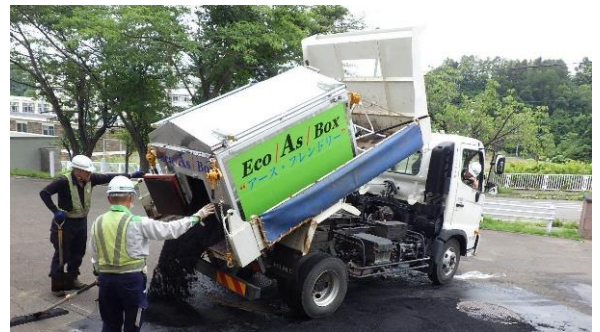
▲ダンプアップを妨げることなく道路に直接合材を落とせるため、作業効率が向上。
