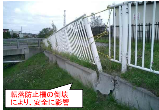
〈 海岸擁壁の劣化による機能低下 〉
