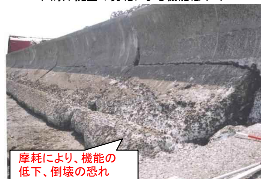
〈 海岸擁壁の劣化による機能低下 〉
