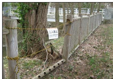
転落防護柵の立入禁止措置 (最上川<岩見沢市> H30.4)
