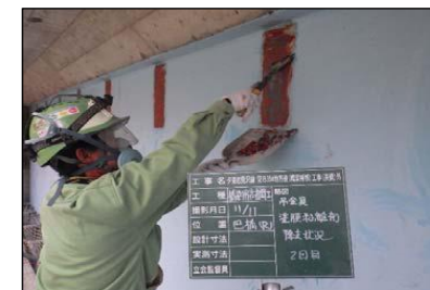
旧塗膜除去でのコスト低減・環境改善 (夕張岩見沢線(巴橋)<岩見沢市> H30.11)
