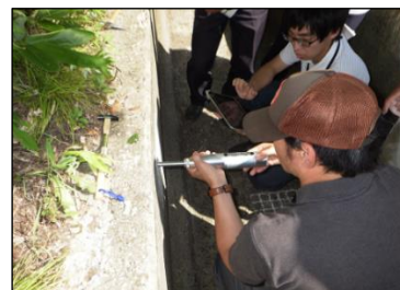
機能診断情報の収集・整理・活用 (用水路_富良野土地改良区 H30.8)
