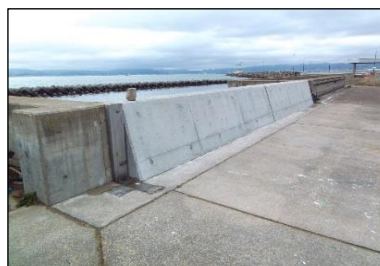
漁港海岸陸閘部の閉鎖 (函館漁港海岸<函館市>)
